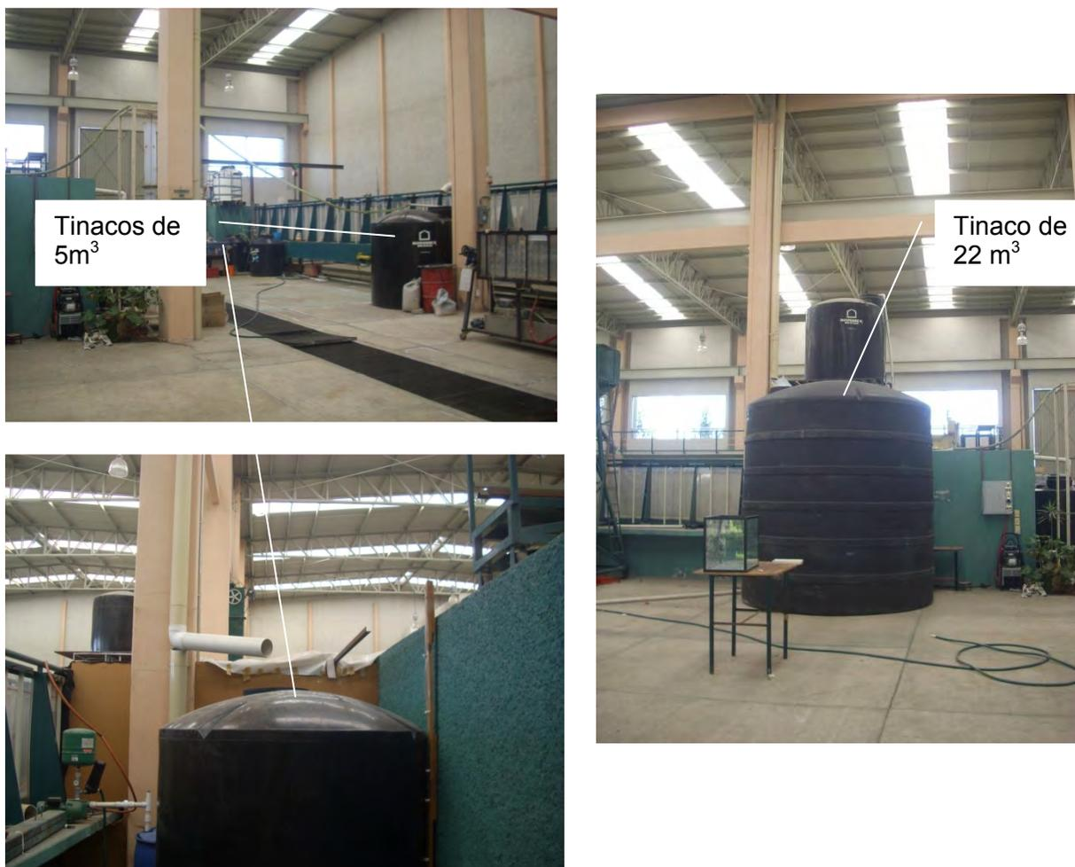
**Figura 11. Reservorios de almacenamiento de agua pluvial**
